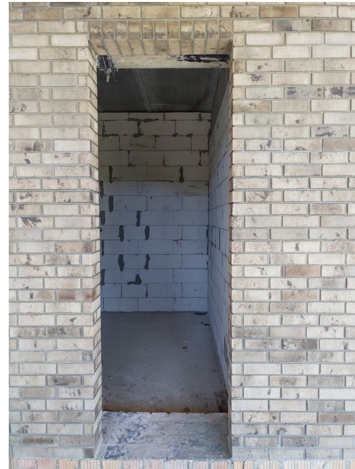
Внешний вид кладки с использованием закладных деталей BRICKO
